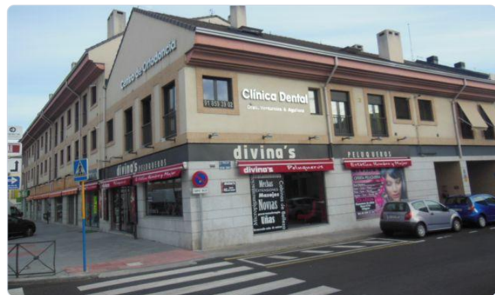
Fotografía de fachada del inmueble registrada por el Catastro.
